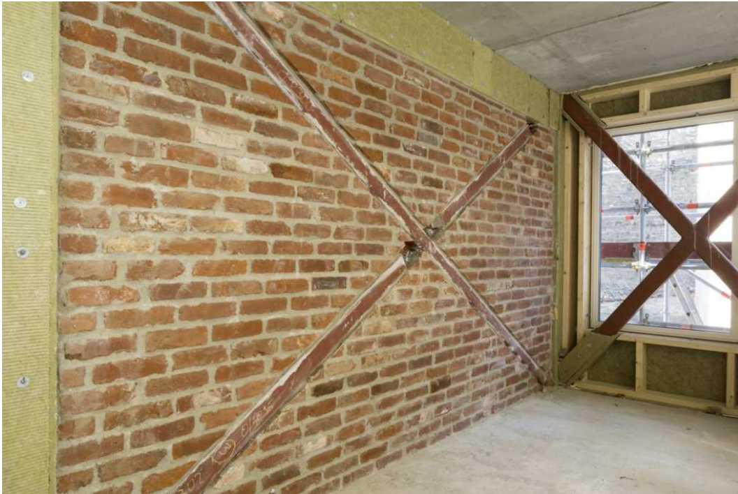
Figur C.5 Monterade stag inmurade i vägg av återvunnet tegel, Murmester Rolf Holm AS
