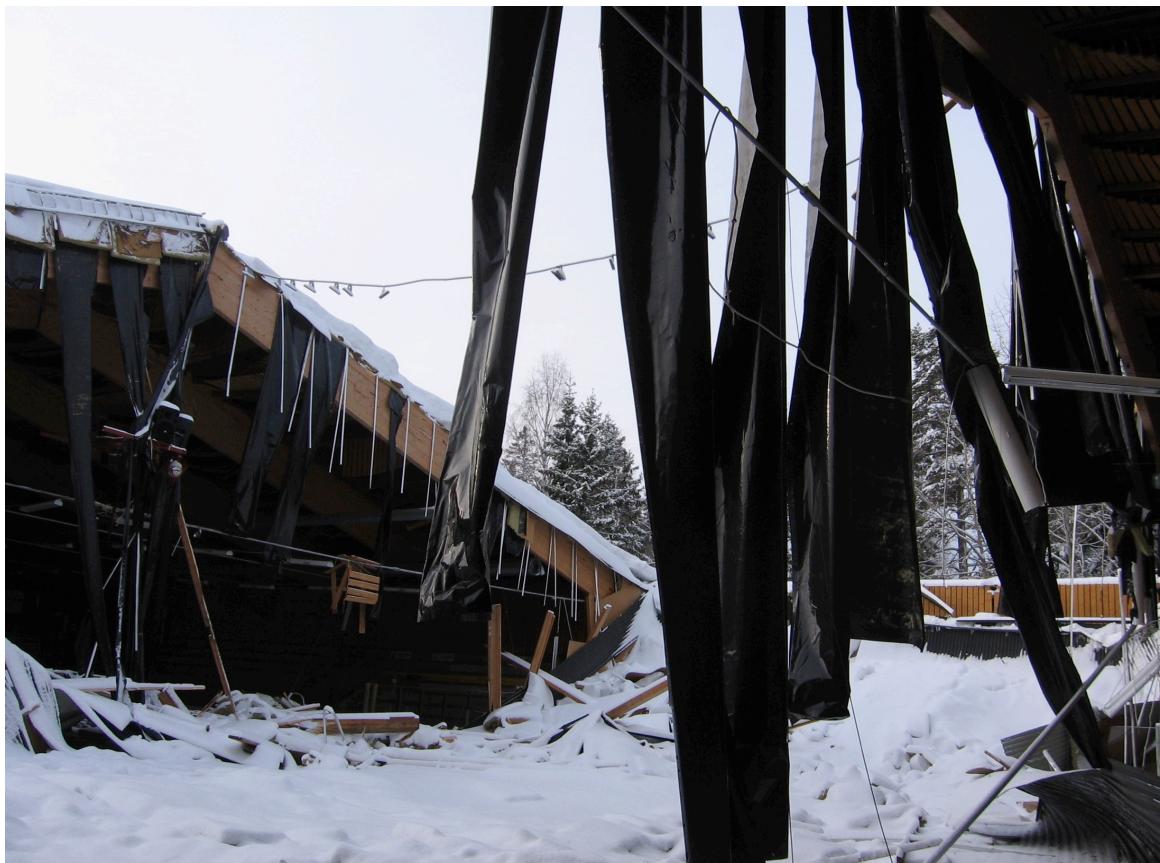
Figur 4.3 Ishall byggd i mitten av 1980-talet, dimensionerad enligt SBN 80. Skadan inträffade i februari 2013 vid en relativt låg belastning i förhållande till dimensionerande last och uppstod genom att takplåten gled isär vidnock vilket fick takåsarna att brista och takbalkarna att tappa sin stagning i sidled. En vanlig lösning för att staga upp takåsarna mot belastningen från takplåten i takfallets riktning är att en så kallad skjuvregel fästs på takbalkarnas översida mellan två takåsar på respektive takbalk. Utredning visade att sådana skjuvreglar saknades och att den ursprungliga nockplåten bytts ut sommaren innan skadan inträffade. Sannolikt höll den tidigare nockplåten ihop taket och fördröjde därmed konsekvenserna av ett ursprungligt fel i nästan 30 år.
